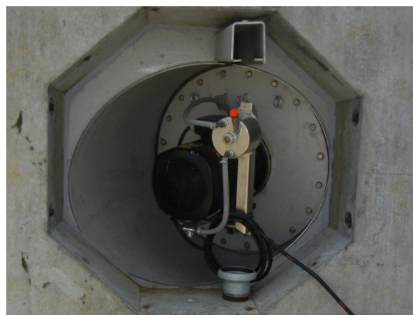
Skærehovedet i snitterpumpe fra Landia og omrører i hygiejniseringsstank
