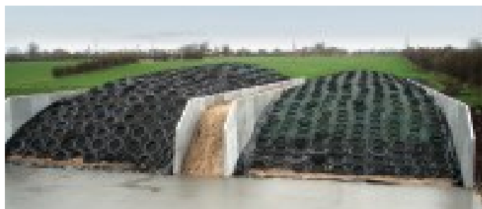
Eksempel på plansilo fra Lundsby Industri og biogasanlæg
