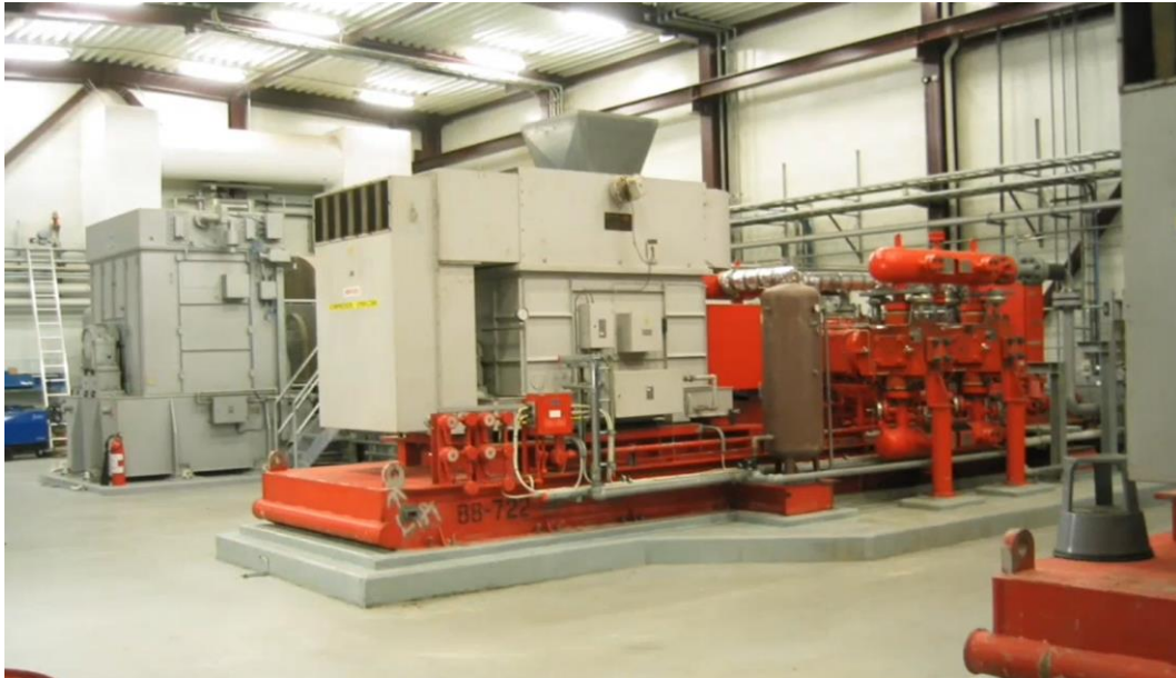
Figur 3-4 – Bygning med kompressorer i Stenlille. 10
