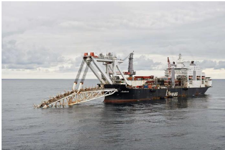
Fig. B-1 Læggefartøj under operation
