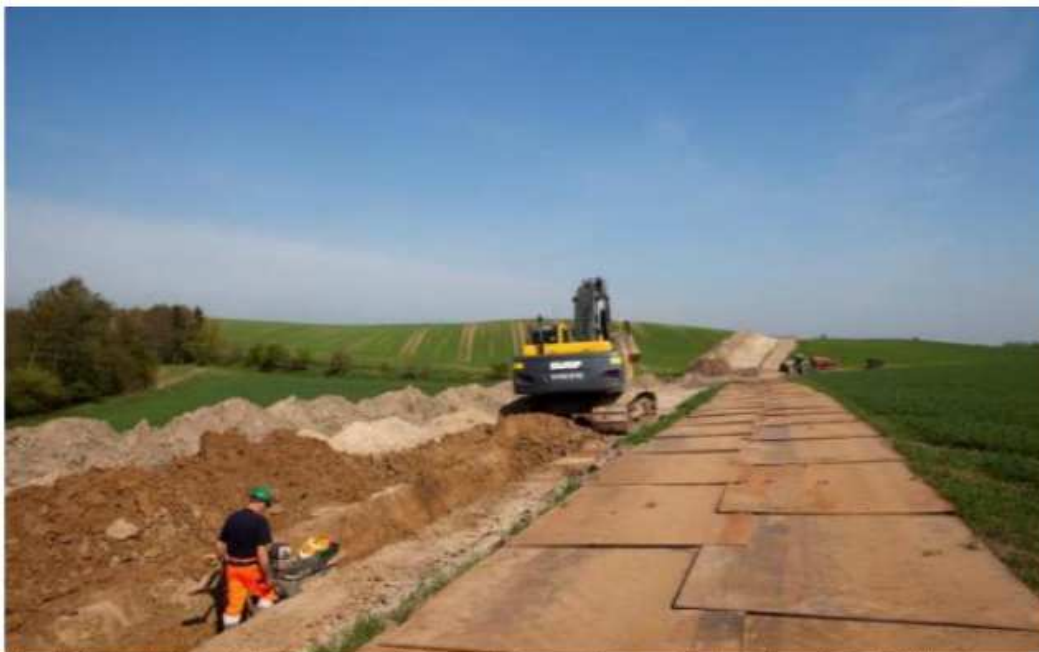
Figur 4 Eksempel på arbejdsbælte langs kabelanlæg med afrømmet rå- og muldjord samt køreplader. På billedet ses et kabeltracé med ét kabelanlæg.
