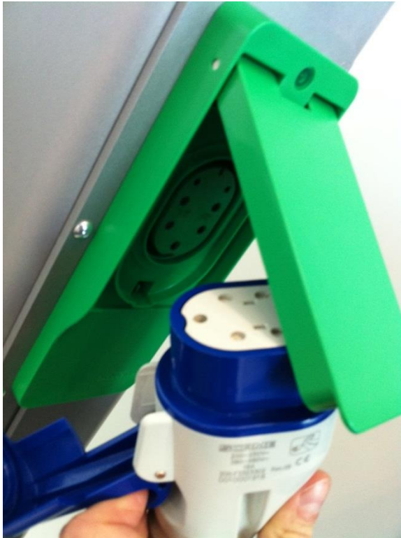
Figur 4 Stiktype 3. Billedet er lånt fra www.greentransportation.info .
