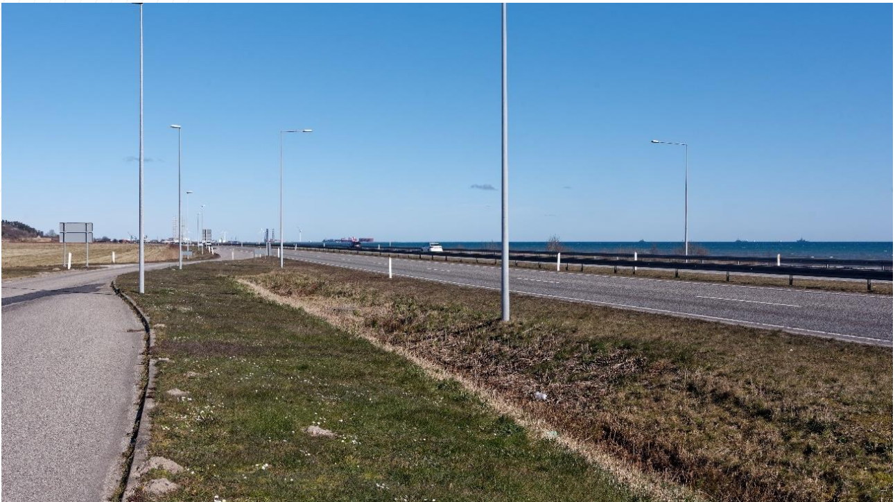
Figur 7.49 Standpunkt 14 (Europavej), eksisterende forhold.
