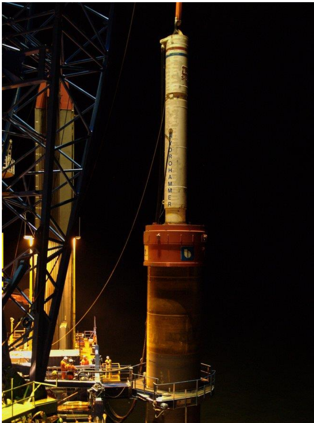
Ramning af fundamenter
