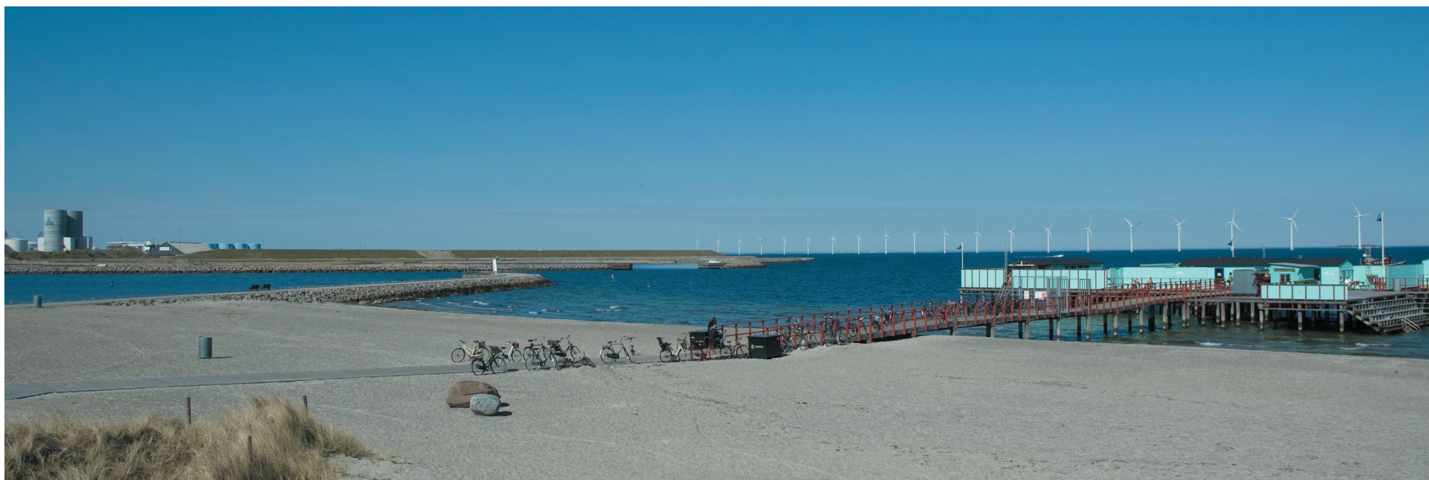
Fotos fra eksisterende vindmøllepark ved et teknisk anlæg - MIDDELGRUNDEN . I alt 20 møller, med en totalhøjde på hver 102 meter, er placeret fra ca. 1 km ud for havnen ved København.
