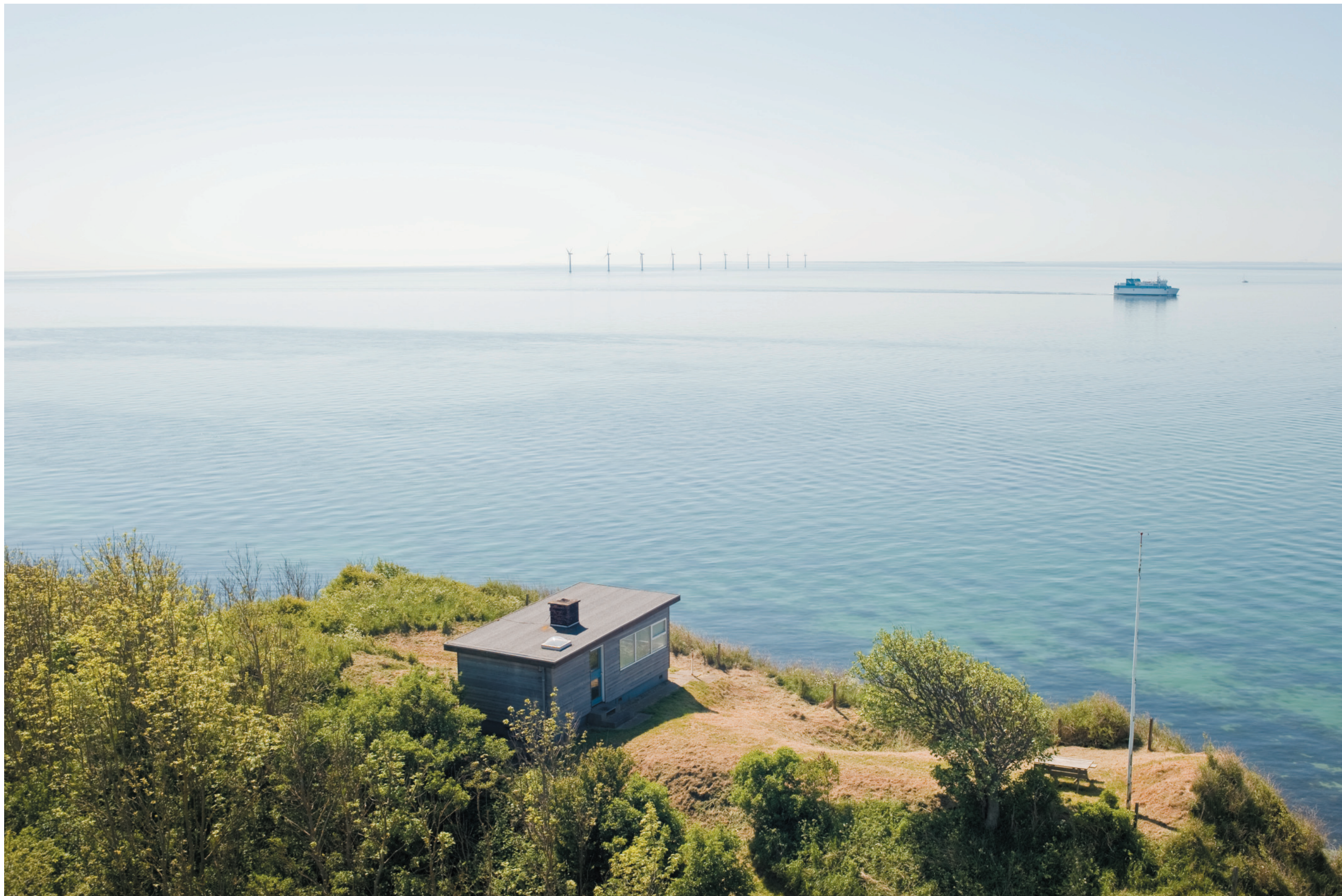
Eksisterende kystnær vindmøllepark - SYD FOR SAMSO . De 10 møller på hver ca. 103 meter totalhøjde har tilsammen en installeret effekt på 23 MW og befinder sig omtrent 4,3 km fra kysten på fotoet.
