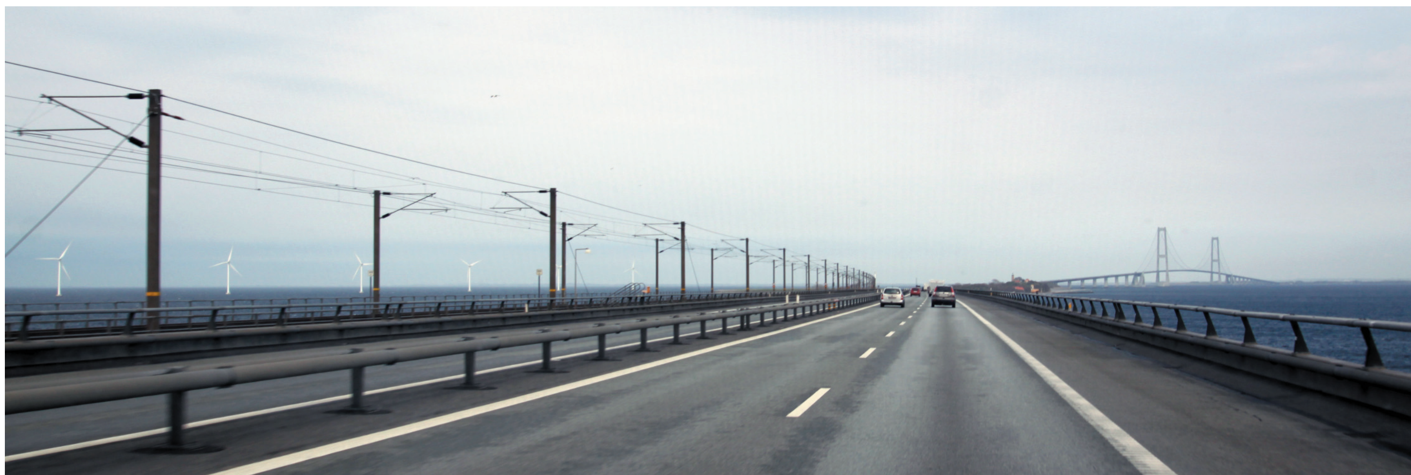
Fotos fra eksisterende vindmøllepark ved et teknisk anlæg - STOREBÆLTSBROEN . De 7 møller, med en totalhøjde på hver 125 meter, er placeret parallelt med øst-broen i en afstand på op til 1,5 km fra broen.
