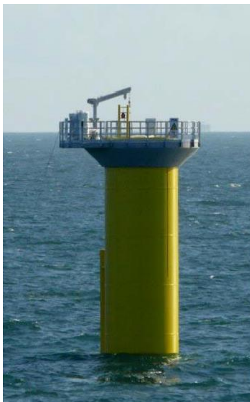
Figur 5.4.1 Monopæl med overgangsstykke, hvorpå platform, landgang mm. er monteret. (Energinet.dk).
