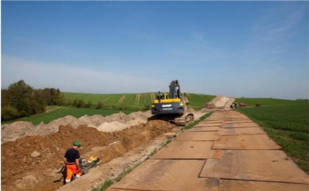
Figur 4-21 Eksempel på arbejdsbælte langs kabelanlæg med afrømmet rå- og muldjord samt køreplader. På billedet ses et kabeltracé med ét kabelanlæg. (Fotografi fra den publicerede Landsaftale for el- og fiberanlæg på landbrugsjord 2019 mellem landbruget og Dansk Energi).
