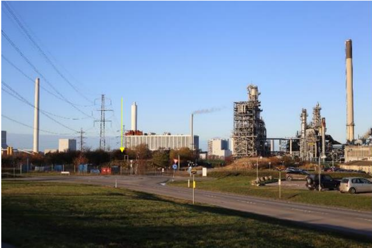
Figur 9-10 Udsigt mod Kalundborg Refinery, Asnæsværket og højspændingsluftledninger fra udsigtspunkt 3, ved rundkørslen syd for området, hvor transformerstationen skal etableres i det grønne område bag rundkørslen, se den gule pil.
