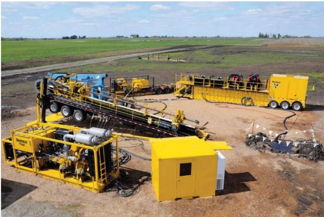
Figur 4-19: Eksempel på byggeplads for en styret underboring
