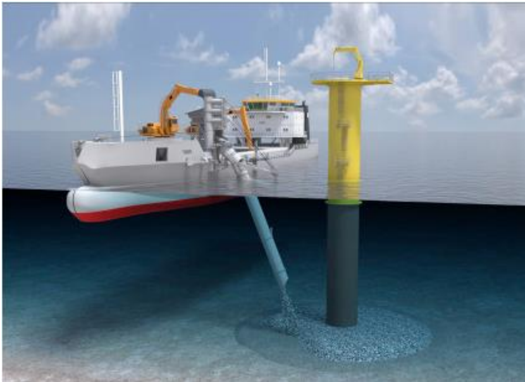
Figur 4-7 Eksempel på udlægning af erosionsbeskyttelse omkring et monopæl fundament (Kilde: Jan de Nul).
