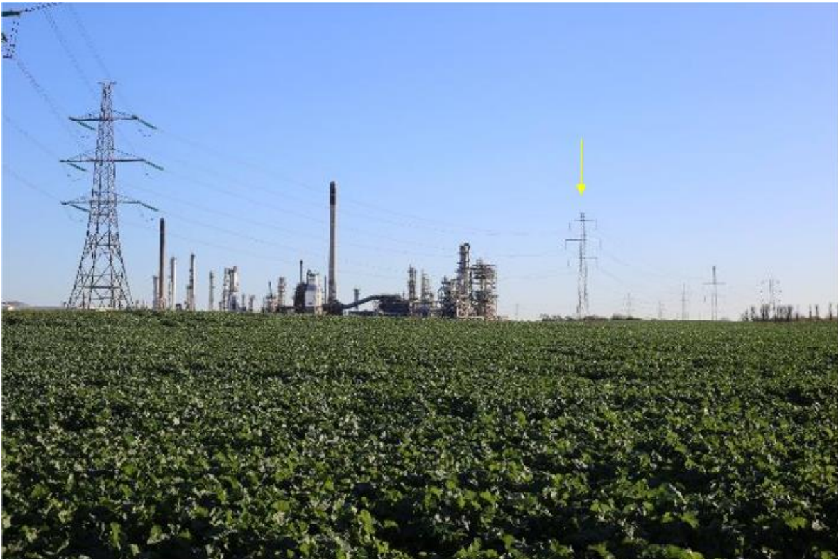
Figur 9-8 Udsigt over mod Kalundborg Refinery og højspændingsluftledninger (set fra udsigtpunkt 1 i Figur 9-7) ved Asnæs Skovvej nord for Lerchenborg Slot før etablering af transformerstationen. Den gule pil angiver omtrentlig placering af transformerstationen.
