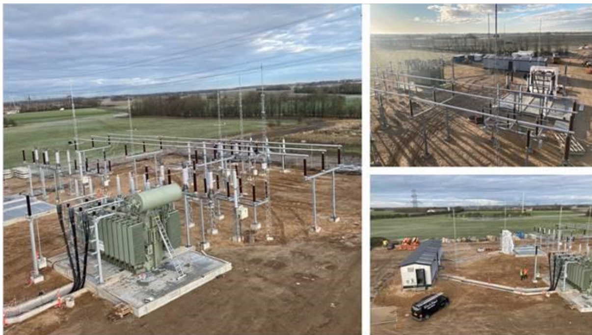
Figur 4-16 På figuren er vist en delvist åben transformerstation, hvor kun dele af anlægget er indkapslet i et teknikhus. Figuren giver et generelt indtryk af udformningen af en transformerstation, men ikke nødvendigvis en præcis angivelse af, hvordan transformerstationen kommer til at se ud i nærværende projekt.
