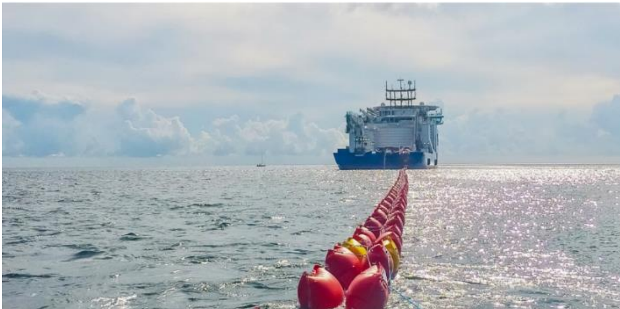
Figur 4-11 Kabelinstallation, som udføres fra et kabelnedlægningsfartøj.
