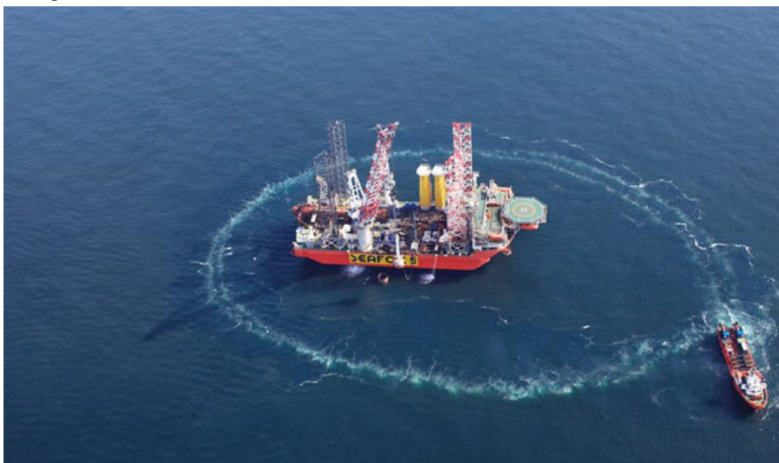
Figur 4-3: Eksempel på dobbelt boblegardin ved monopæl nedramning (kilde: Vattenfall).
