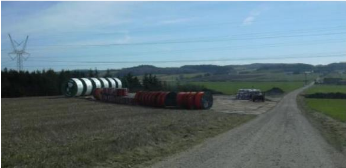
Figur 4-23 Eksempel på tromledepot, som er et midlertidigt oplags- og arbejdsområde.
